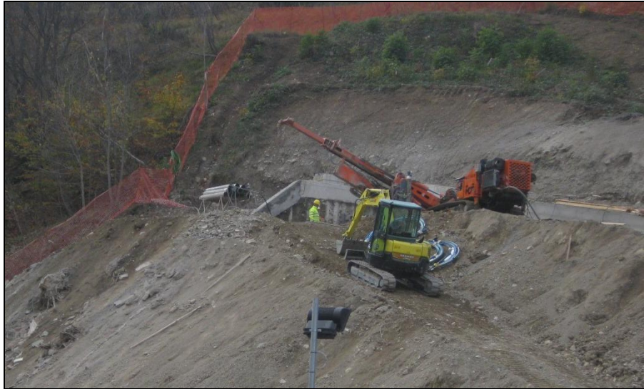
Deux vues du chantier versant italien, on entrevoit où sera positionnée l'entrée [31.10.2014]
