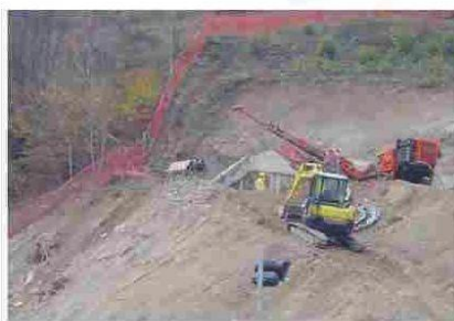
Vista dei lavori lato Italia dove verrà posizionato l'imbocco
