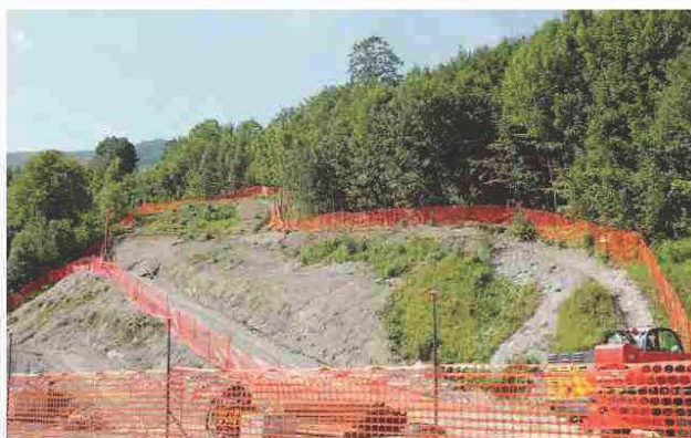
Il cantiere dal versante italiano del Colle: sono in corso sondaggi di drenaggio con una perforatrice
