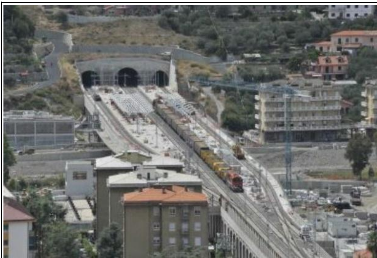
Planche 2 Nouvelle gare d'Imperia – Chantier du viaduc et de la triple tête de tunnel Ouest
